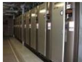
瓦斯化燃燒的小型鍋爐
