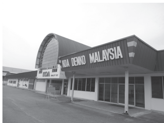
写真1 興亜電工マレーシアの外観
