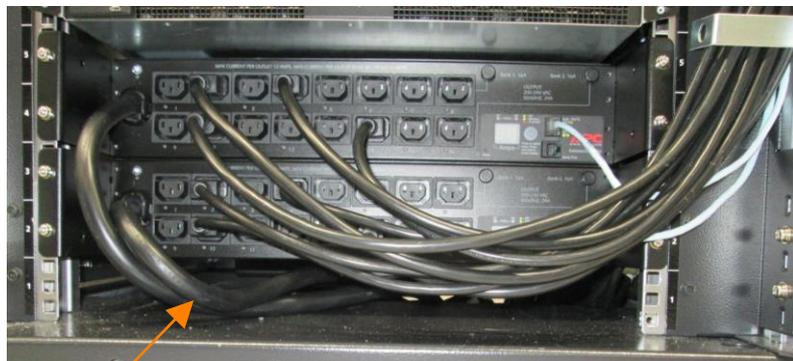
PDU本体の電源ケーブルは下の空きユニットを通す
