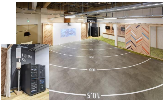
検証エリア1 (200㎡) / 屋外アンテナ
