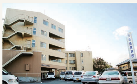
8 月に完全復旧した石巻港湾病院
