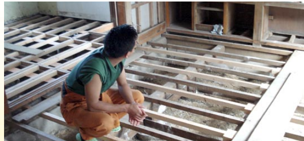
応急対処作業中の住宅
