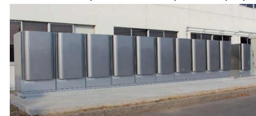
Fuel cell power generators (Kumagaya SSC)
