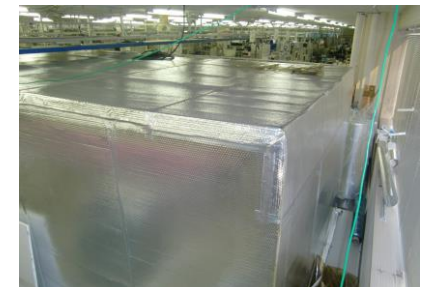
バーインの断熱 (新潟工場)
