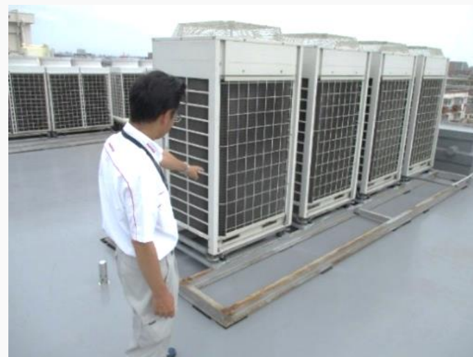
エアコン室外機の簡易点検
