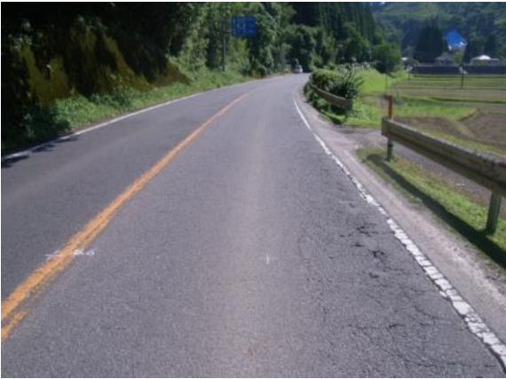
宮崎県都城市高岡町 唐崎トンネル口の路面の写真（補修前・補修後）
