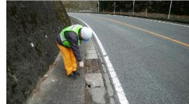
側溝の蓋の破損記録
