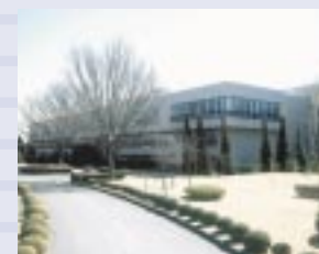
館林システムセンター
