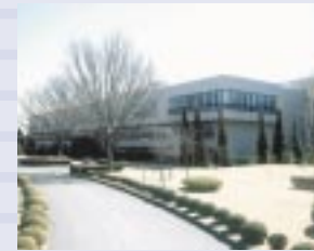
館林システムセンター
