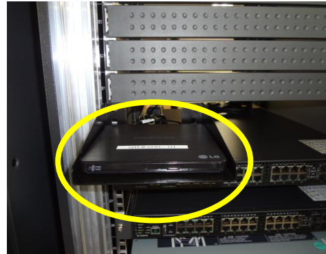
[M5 ネジでヒンジを取り付け本体をセット]
