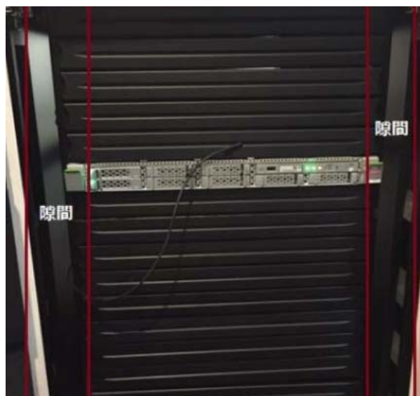
図 4.4.1 ラックマウント部のみブランクパネルで塞いだ状態
