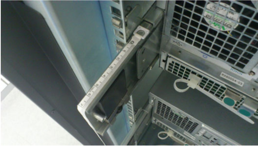
図 23-1. PDU 取付け面の考慮が必要なラックマウントレール例
