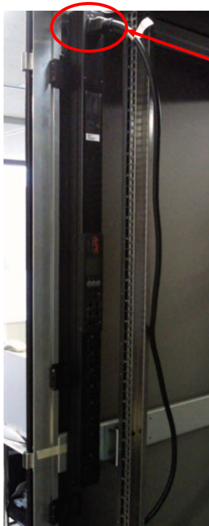
図 19. AP8958(Switched Rack Mount PDU)取付け写真
