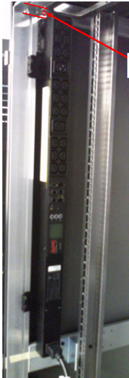
図 16. AP8858 取付けイメージ (ラック上部)
