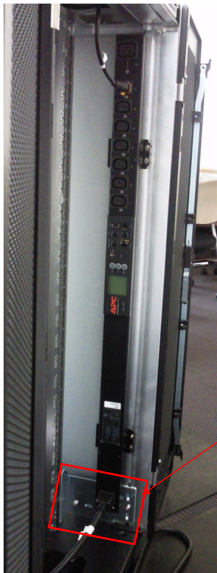
図 16. AP8958(Switched Rack Mount PDU)取付け写真
