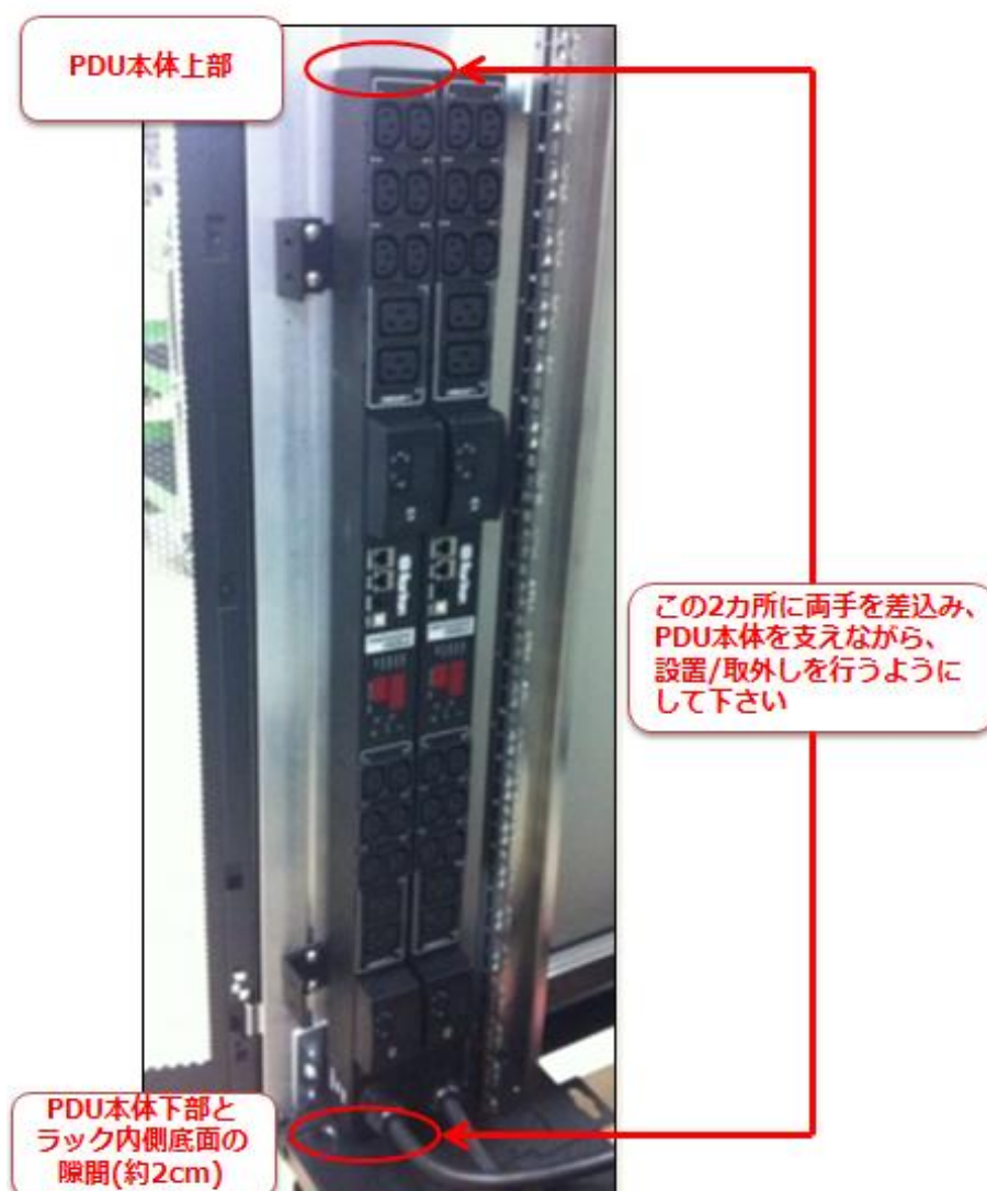
図 4-⑤. PDU の設置/取外し方法について
