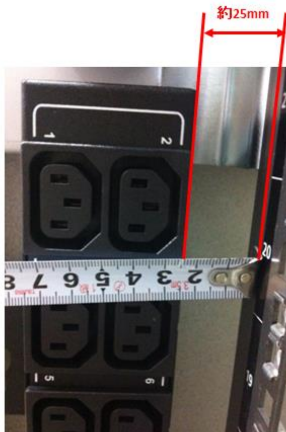
図 5-①. PDU 搭載時(内側)のサーバレールとの間隔(25mm)
