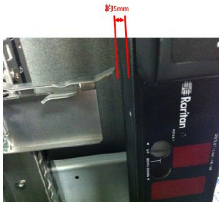
図 5-②. PDU 搭載時(内側)のサーバレールとの間隔
