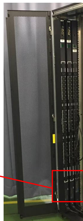
&lt;図 52. PDU を 3 本取付ける場合&gt;
