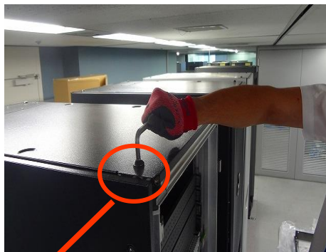
2) トップカバーを留めているボルトを外す。 ※前扉側左右1カ所ずつ(計2カ所)
