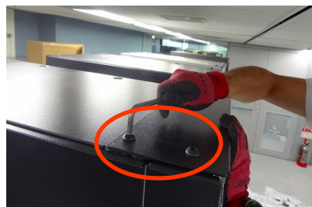
6) 前扉側左右1カ所ずつボルトで固定する。 (計2カ所)
