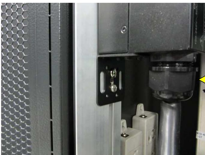
電源ケーブルがPDU本体に直接接続されている為、金具をラックに取り付ける際に干渉します。
