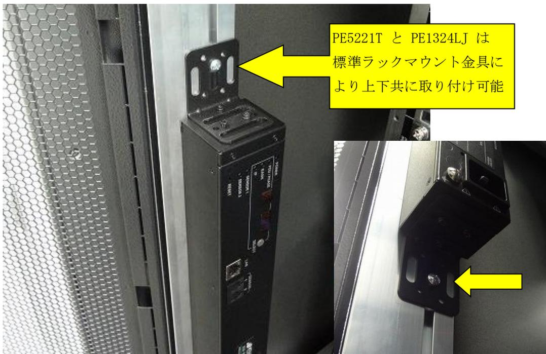
PE5221TおよびPE1324LJ取り付けは、モデル 2742 のラック背面の両サイドの溝にコアラットを使用して左右へ1本ずつ計2本のPDUを搭載可能であることを確認致しました。
