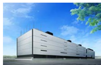
データセンター（館林）
