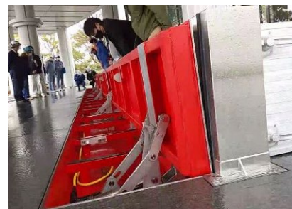
起伏式ゲート
