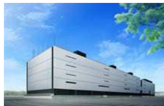
データセンター(館林)
