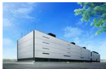
データセンター（館林）
