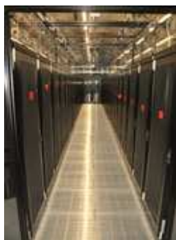
コールドアイルキャッピングとブランクパネル 左 Germany、右 UK
