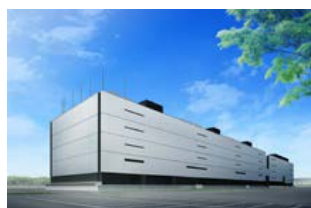
データセンター（館林）
