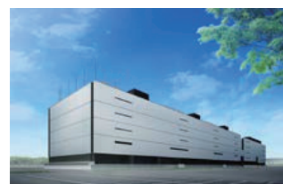
データセンター (館林)
