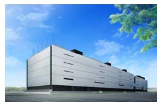
データセンター(館林)
