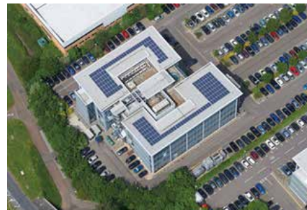
太陽光パネルが設置された屋上
