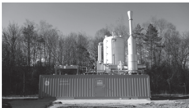
図-7 アウグスブルグ事業所の熱電併給システム
