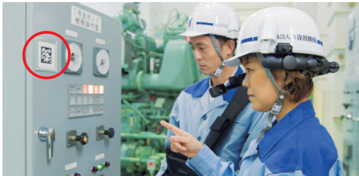
設備に貼られたARマーカ―(赤丸箇所)を認識すると、作業手順を示すカードが表示される。
