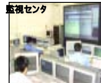
監視センター
