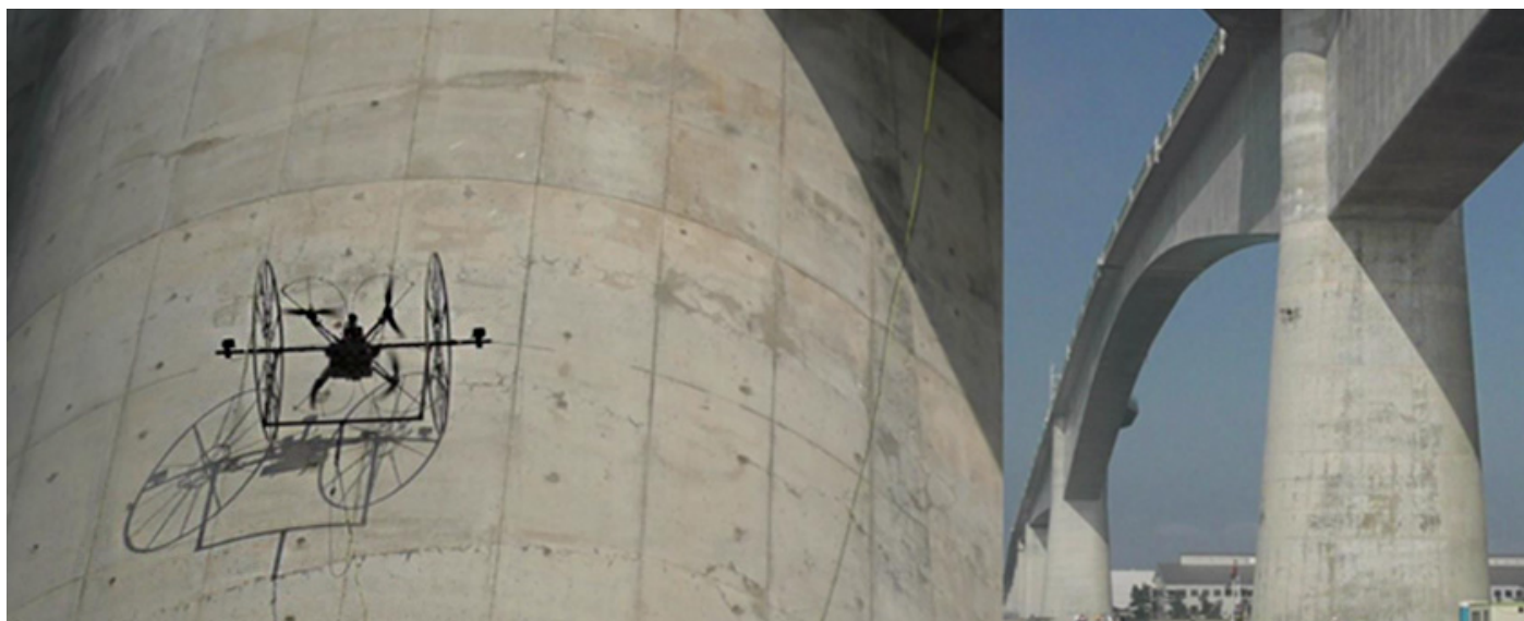
壁を這い橋梁を点検するドローンの様子
