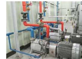
冷却装置に水を戻す導水管(青色部)
