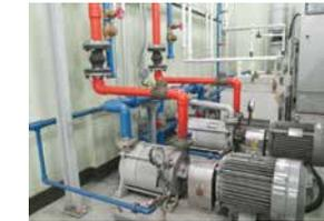
冷却装置に水を戻す導水管(青色部)
