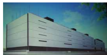
館林データセンター新棟外観
