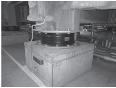
(a) 積層ゴム免震装置
