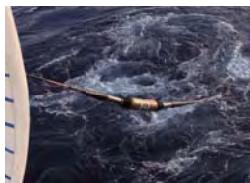
通信システム敷設の様子
