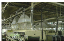
リフロー炉へ排熱ダクト、断熱ジャケットの設置
