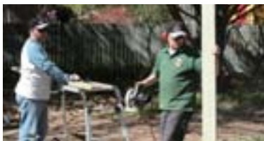
障がい者施設の修理
