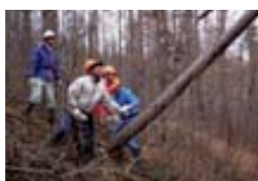
長野県飯綱町での間伐作業
