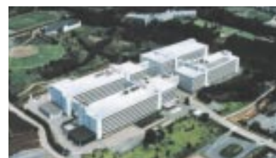
沼津工場全景
