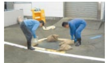
受入時に漏洩した塩酸をゴムシートとオイルマットにより流出を防ぐ[富士通アイソテック]
