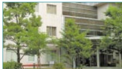
富士通川崎病院外観
