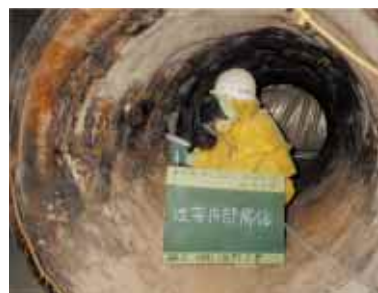
焼却施設煙突内部解体（富士通沼津工場）
