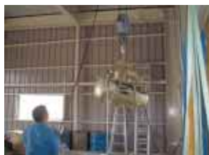
製造設備解体(富士通岩手工場)
