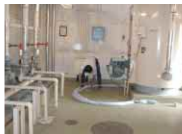
オイルフェンスを張り拡散を防止する(九州富士通エレクトロニクス)
