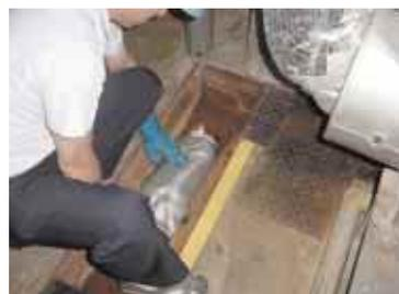
排水溝上部に土のうを設置し、下水への流入を防止する(富士通宮城エレクトロニクス)
